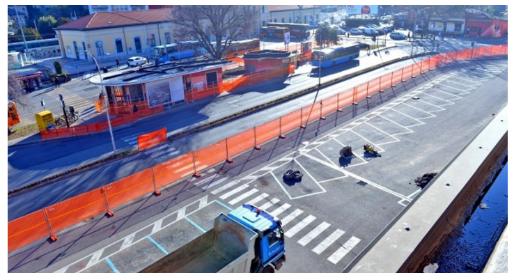
Lavori in zona stazioni
